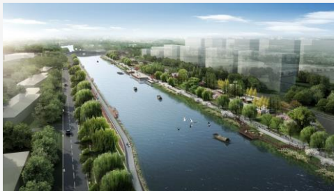
▲副中心水环境治理PPP建设项目
