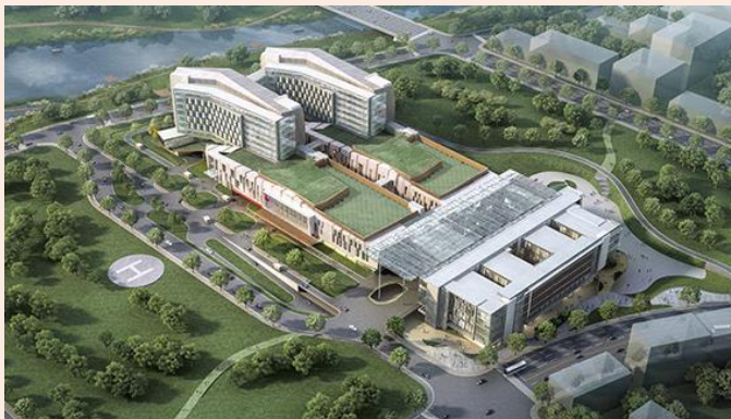
▲雄安医院一期项目
